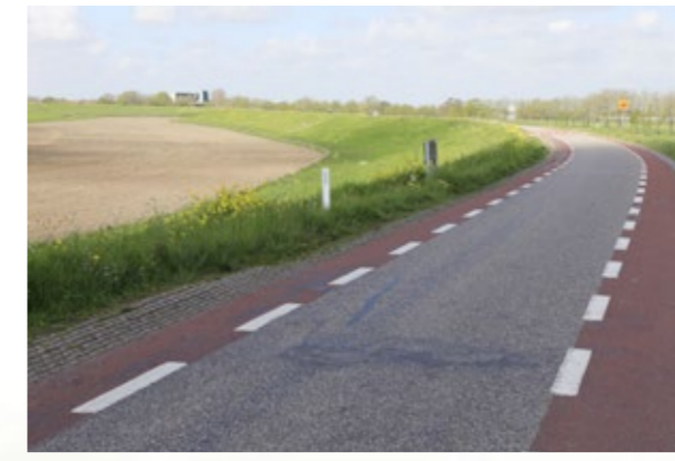
1. Lekdijk nabij Den Oord op zijn oorspronkelijke locatie
