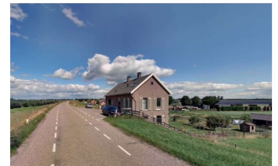
Het oude waakhuis aan de dijk met op de achtergrond bebouwing van Den Oord.
